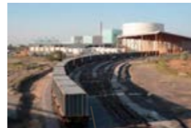
Réception des déchets qui arrivent par train
