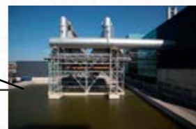
Traitement des eaux
