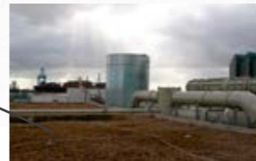
Traitement de l'air par biofiltre
